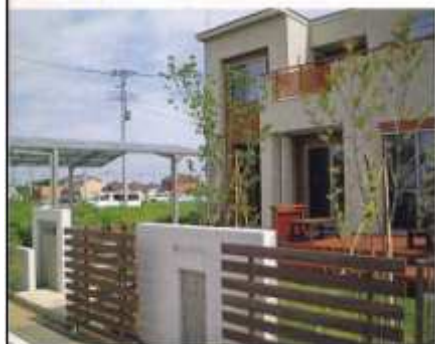
② 左側はNさんご希望のカーポートを設置。建物と調和のとれたエクステリアに。
