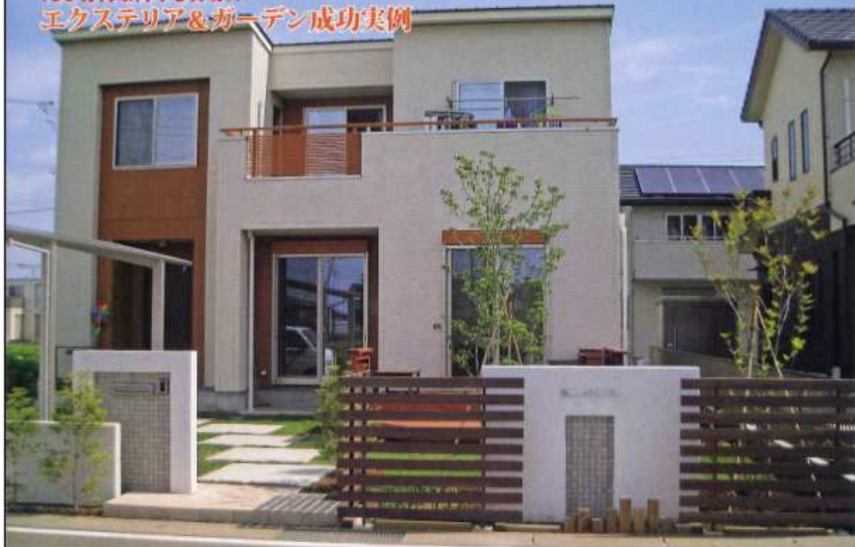
① 全景。素材の個性を引き出したエクステリアに。樹木は左からドウダンツツジ、ドウダンツツジ、ヤマボウシ、アオダモ。ウッドデッキは他社施工。
