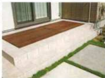
⑦ アイアンウッド・タイルのデッキ。ウッ ド部分は取り外し可能。中に排水管を設置。
